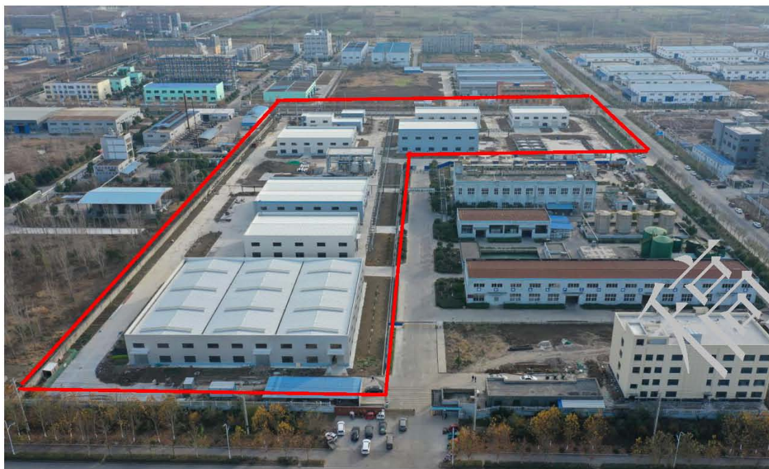
主体工程现状全景图
