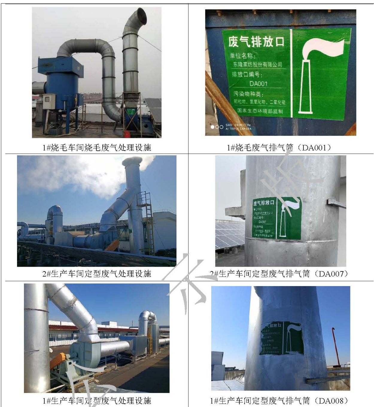
图 3-9 整改措施落实情况现场设施照片
