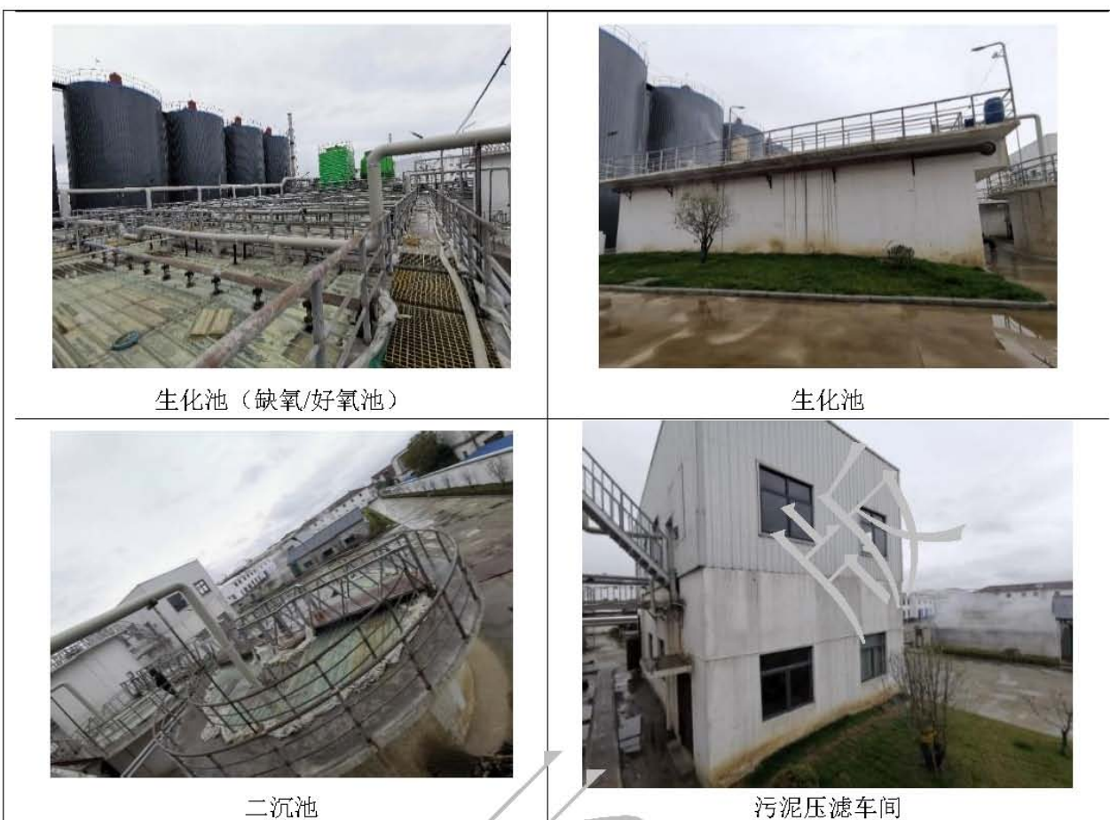
图 3-3 练漂废水处理设施建设情况
