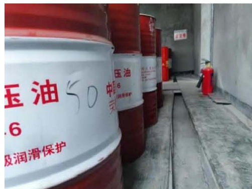
危废暂存间导流沟、收集槽
