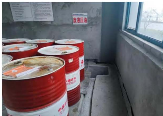
危废暂存间导流沟、收集槽
