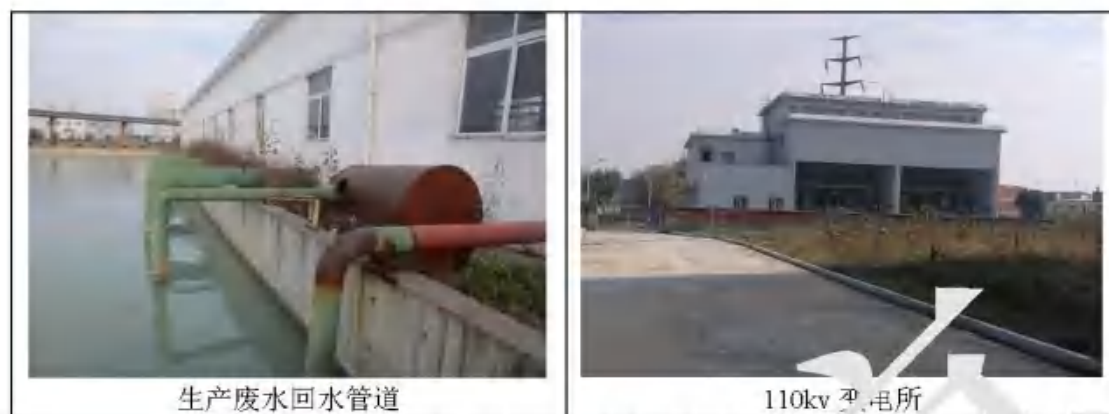
图 2.5.3-1 工程建设情况
